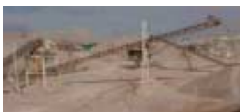
Tratamiento y Valorización de RCD
